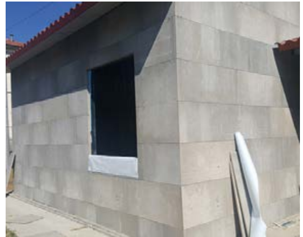
Il sistema di pareti e contropareti in cementolegno BetonWood® N e lamiera grecata Betonmetal sheet su telaio metallico è raccomandato sia nelle nuove costruzioni che nelle ristrutturazioni.
